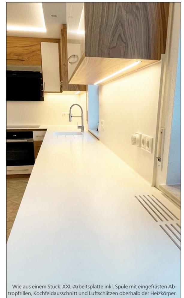
Wie aus einem Stück: XXL-Arbeitsplatte inkl. Spüle mit eingefrästen Abtropfrillen, Kochfeldausschnitt und Luftschlitzen oberhalb der Heizkörper.
