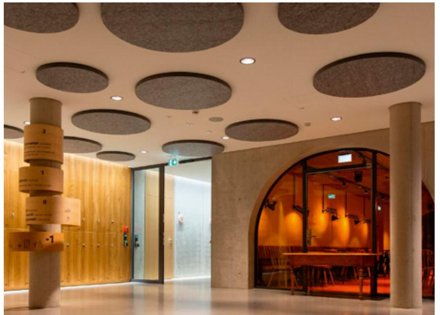
Sonatech „pure+“ besteht zu 30% aus recycelten PES-Fasern und kann erneut recycelt werden. Zudem ist es gemäß DIN 4102 als schwer entflammbar (B1) zertifiziert. Foto: Sonatech | [www.sonatech.de](http://www.sonatech.de)
